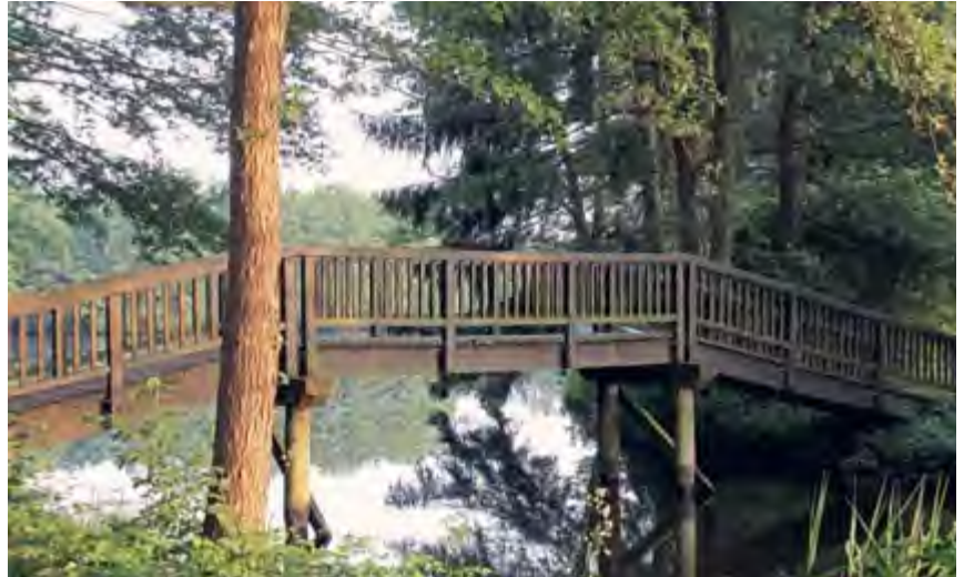
Brücken bauen und erhalten, Peter Weidemann in Pfarrbriefservice.de
